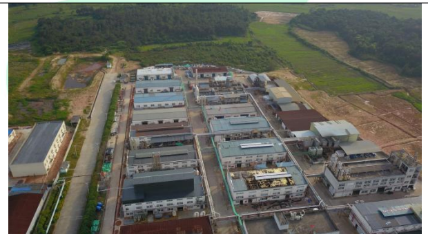
西南面荒山园区预留地
